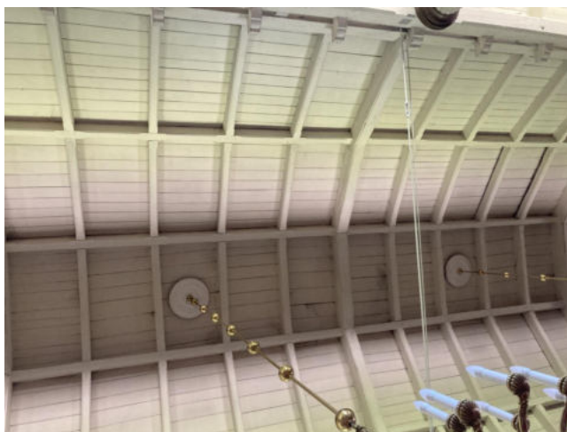
Zdj. 4 Sklepienie drewniane nad nawą.
